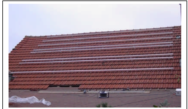
Bild 4: Dachfläche mit fertiger Unterkonstruktion
