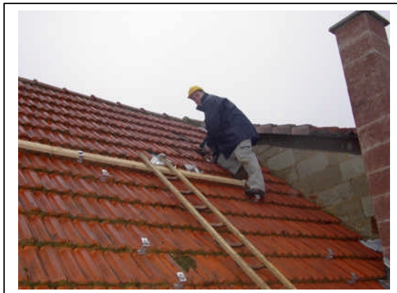
Bild 3: Das Setzen der Sparrenanker
