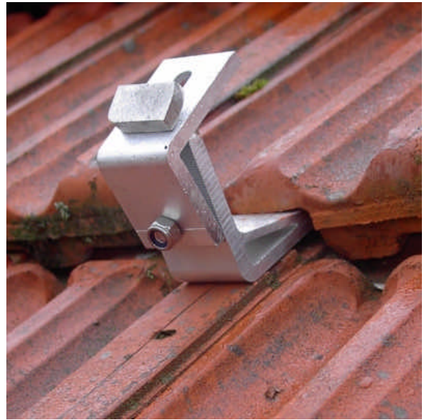
Bild 2: Sparrenanker mit ausgeschnittener Dachpfanne
