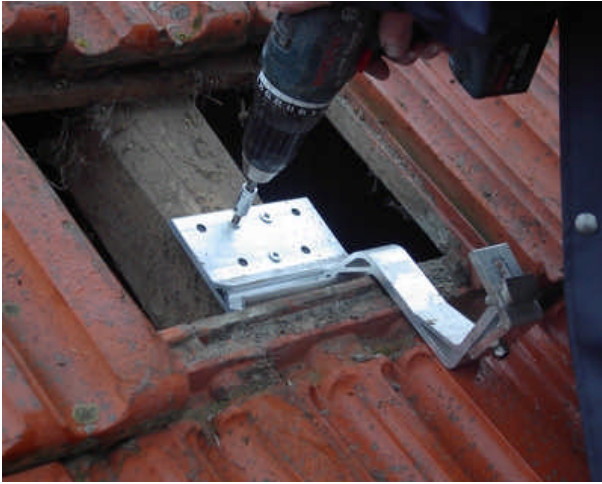
Bild 1: Befestigung der Sparrenanker auf dem Sparren
