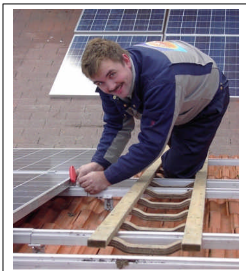
Bild 5: Einzelmodulmontage mit Spezial-Klemmhaltern
